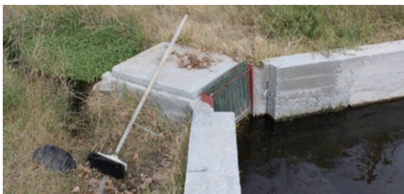
民間ニジマス養殖池の排水溝。写真では分かりにくいですが、池の底面より排水路の方が高い。
